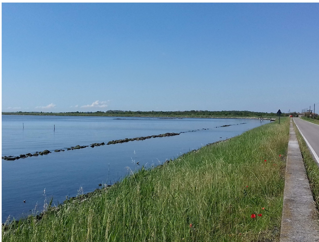
Fig. 3 – Vista di parte del molo n. 3 con punto di ripresa in direzione E-NE dall’argine di I linea della Sacca degli Scardovari; si nota la parziale sommersione in condizioni di marea ordinaria – quota m 0,35 s.l.m.m. (ore 11:30 del 31.05.2019)
