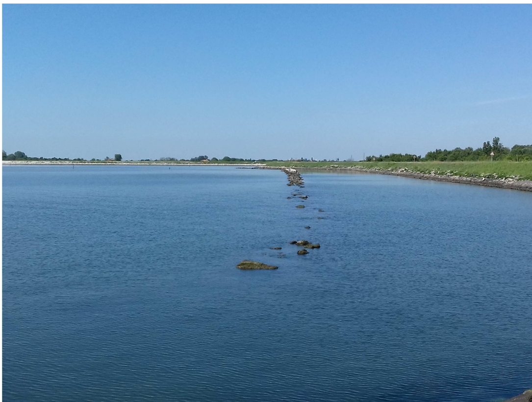
Fig. 4 – Vista di parte del molo n. 6 con punto di ripresa in direzione W-NW dall’argine di I linea della Sacca degli Scardovari; si nota la parziale sommersione in condizioni di marea ordinaria – quota m 0,35 s.l.m.m. (ore 11:30 del 31.05.2019)
